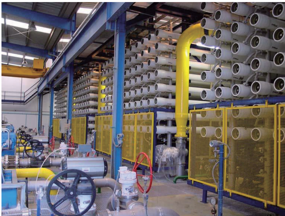
西班牙 Lanzarote 岛 (Inalsa) 使用 FILMETC 反渗透膜元件将海水淡化为饮用水。选用了 iLEC 端面自锁连接膜元件使整个过程更简单并节省了费用 (图片由 Inalsa 友情提供)。
