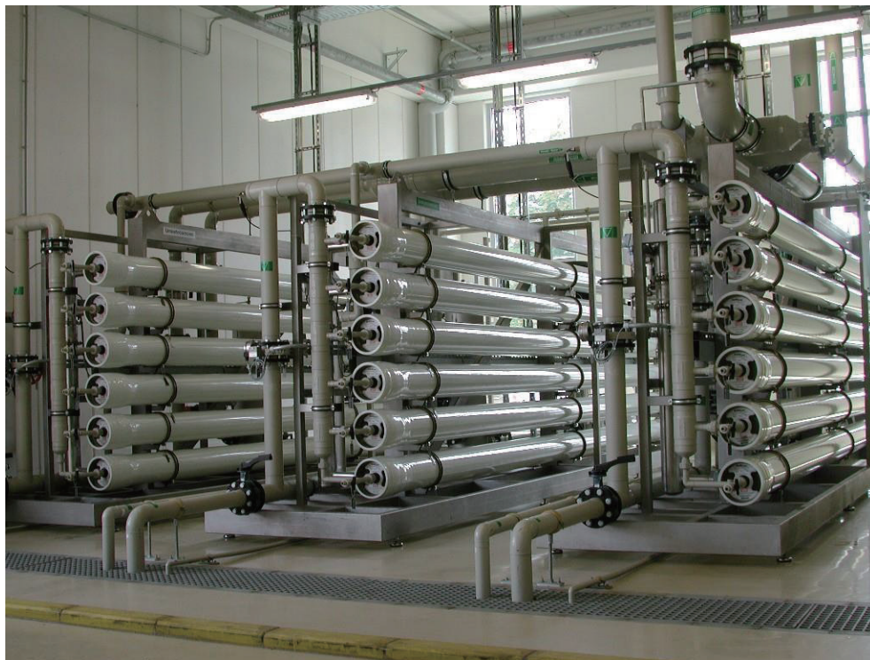
位于德国 Freising 的德克萨斯仪器公司半导体厂选用了 iLEC 端面自锁连接技术解决了泄漏问题（图片由德克萨斯仪器公司友情提供）
