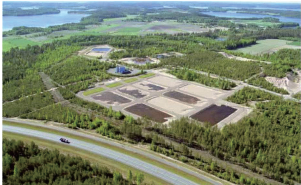
芬兰南部 Kuivala 水处理厂鸟瞰图。该厂使用 FILMTEC™ 极低压（XLE）反渗透膜去除饮用水中含有的氟化物。照片由 Kymenlaakso 水厂提供。
